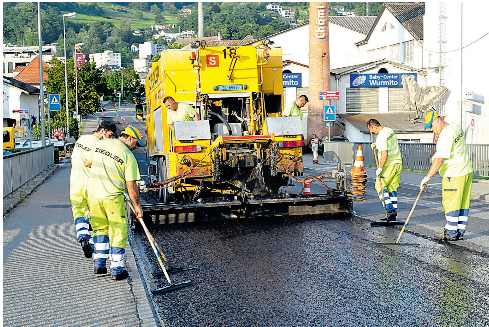
Das Team der Firma Ziegler baut den Mikrobelaag im modernen Kaltverfahren ein.
