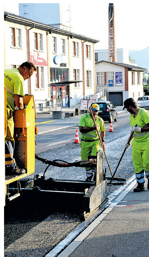
Bereits eine Stunde nach Beginn der Arbeiten sind zwei Schichten eingebaut.
