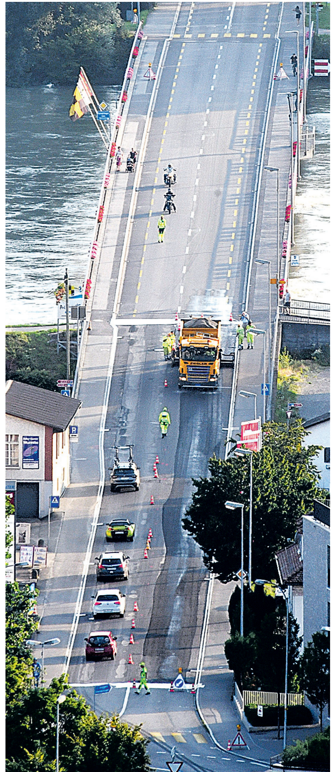
Dienstag, kurz nach 19.30 Uhr, beginnt die Belagssanierung auf der Hauptstrasse zwischen Monti-Kreisel und Aarebrücke. Der Verkehr wird einspurig geführt.
