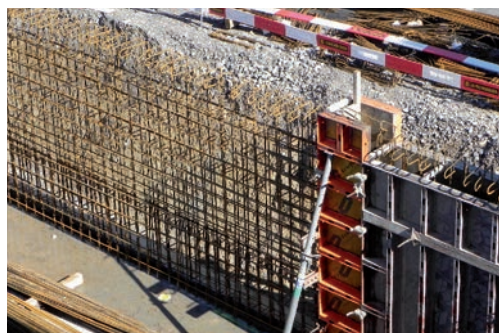
Armierungseisen in den Wänden
