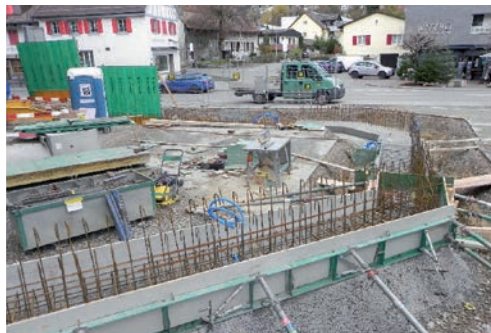
Betonieren der Stützmauer
