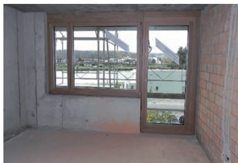
Eingebaute Fenster im Bewohnerzimmer
