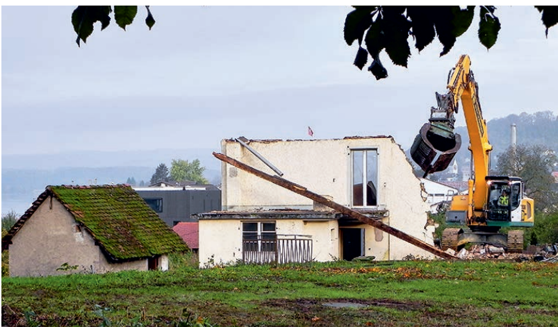
Abbrucharbeiten des Mauerwerkes
