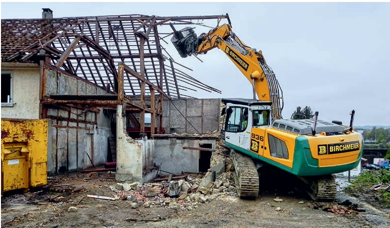
Abbruch des Dachstockes
